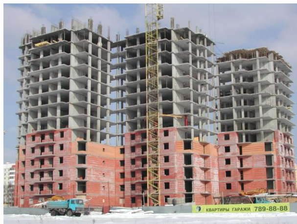
Рис.37. Строительство жилого дома
