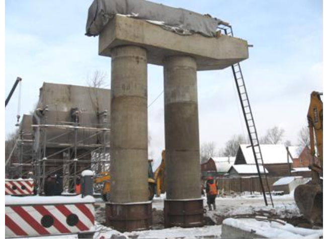
Рис.38. Строительство скоростной железной дороги Шереметьево-2
